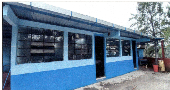
Foto 4: Se observa cubierta de lámina y canal con pescantes instalados, en el módulo 4.
