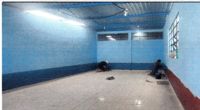
Foto 2: Aula 1 del módulo 4, Se observa lámina troquelada instalada y pintura nueva aplicada.
