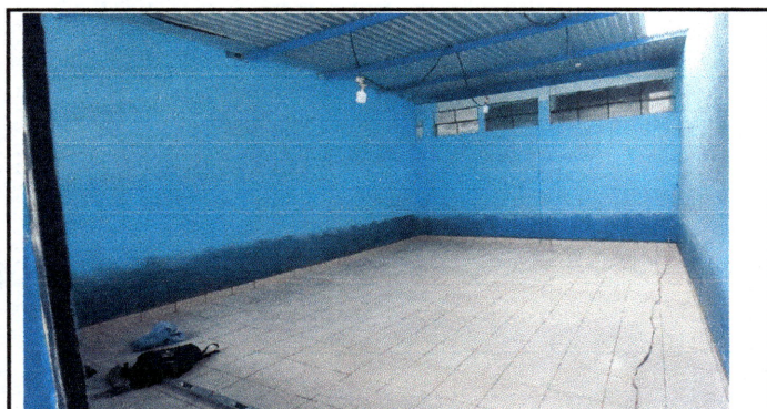
Foto 3: Aula 2 del módulo 4, Estructura de techo restaurado, lijado y pintado con anticorrosivo azul y cubierta de lámina instalada
