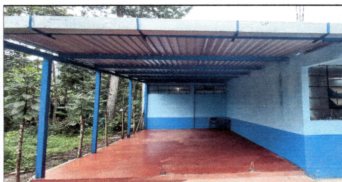
Foto 5: Módulo 4, Se observa piso nuevo color rojo sustituido.
