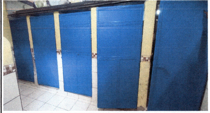
Foto 8: Módulo Baños, Se observa puertas de baños con mantenimiento correctivo realizado.
